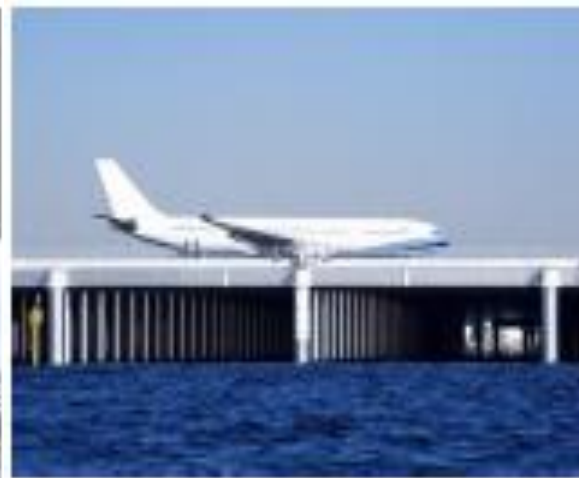
東京都：羽田空港D滑走路栈橋
