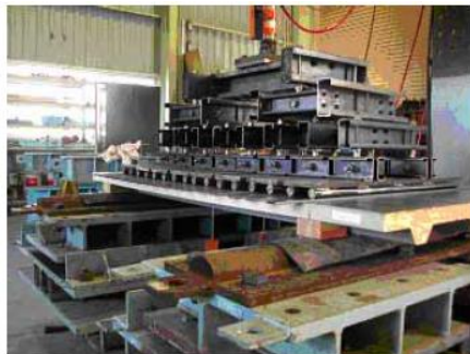
写真-2 チタンパネルの曲げ試験状況
