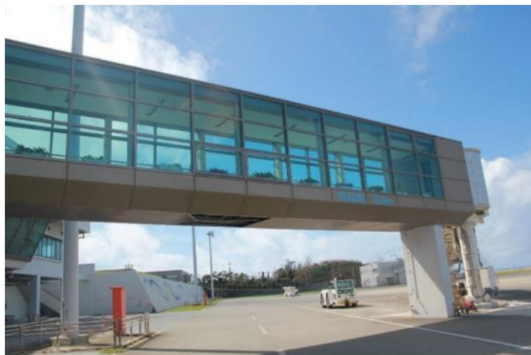
久米島空港 連絡橋 化粧板 損傷状況 (2016年台風18号)
