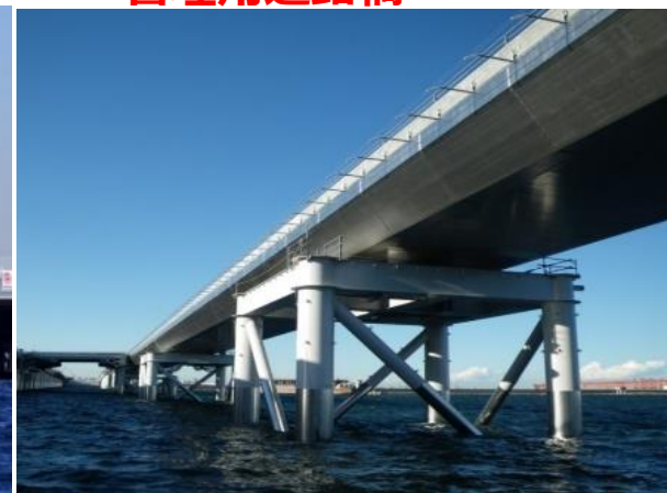
管理用道路橋
