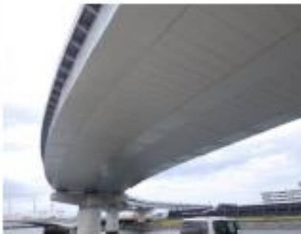
福岡県：アイランドシティ高架橋
