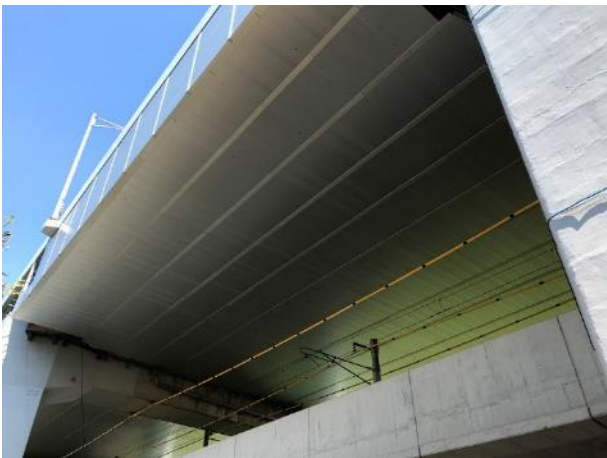
香川県：櫃石島高架橋
