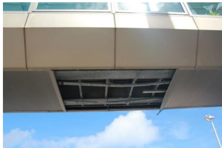
久米島空港 連絡橋 化粧板 損傷状況 (2016年台風18号)
