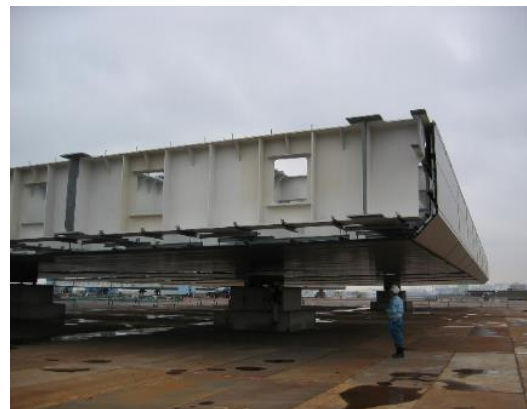
地組場での設置
