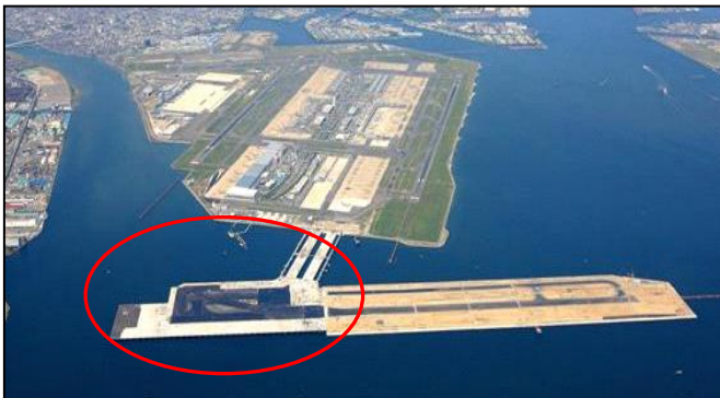
D滑走路棧橋・連絡橋完成状況
