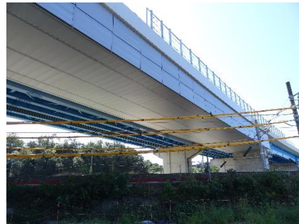
和歌山県：小熊高架橋
