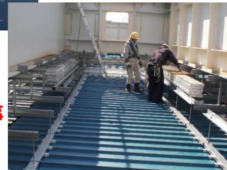
海上設置工事
