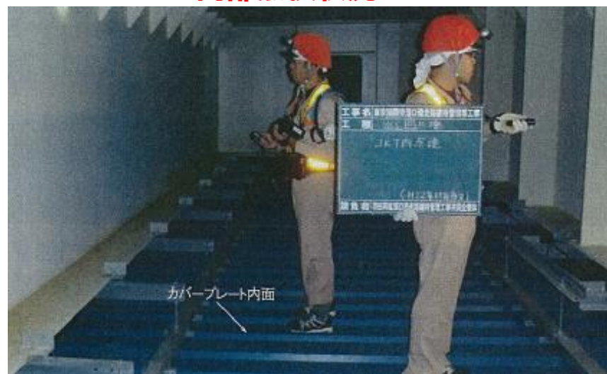
内部点検状況
